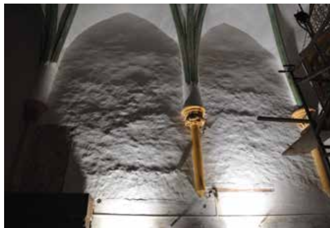
15. kép: Ugyanaz a részlet infravörös felvételen. A fekete rajzos elemek sokkal jobban dominálnak. A rajz megfelelően kinagyítva kitűnően tanulmányozható. A kék festék sötétben jelenik meg, ezért jobban behatárolható, hogy hol maradt meg. A vakolat hiányok világosabb tónusban határozottan felismerhetők.
