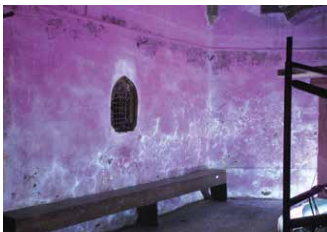
2. kép: A szentély északi fala UV lumineszcens felvételen. Az alsó rész felől a talaj eredetű nedvesség által felszállított sók és szerves anyagok világítanak az UV sugárzás hatására. A világos foltok mutatják a falban meglévő károsító anyagok, - sók és szerves anyagok - elhelyezkedését.
