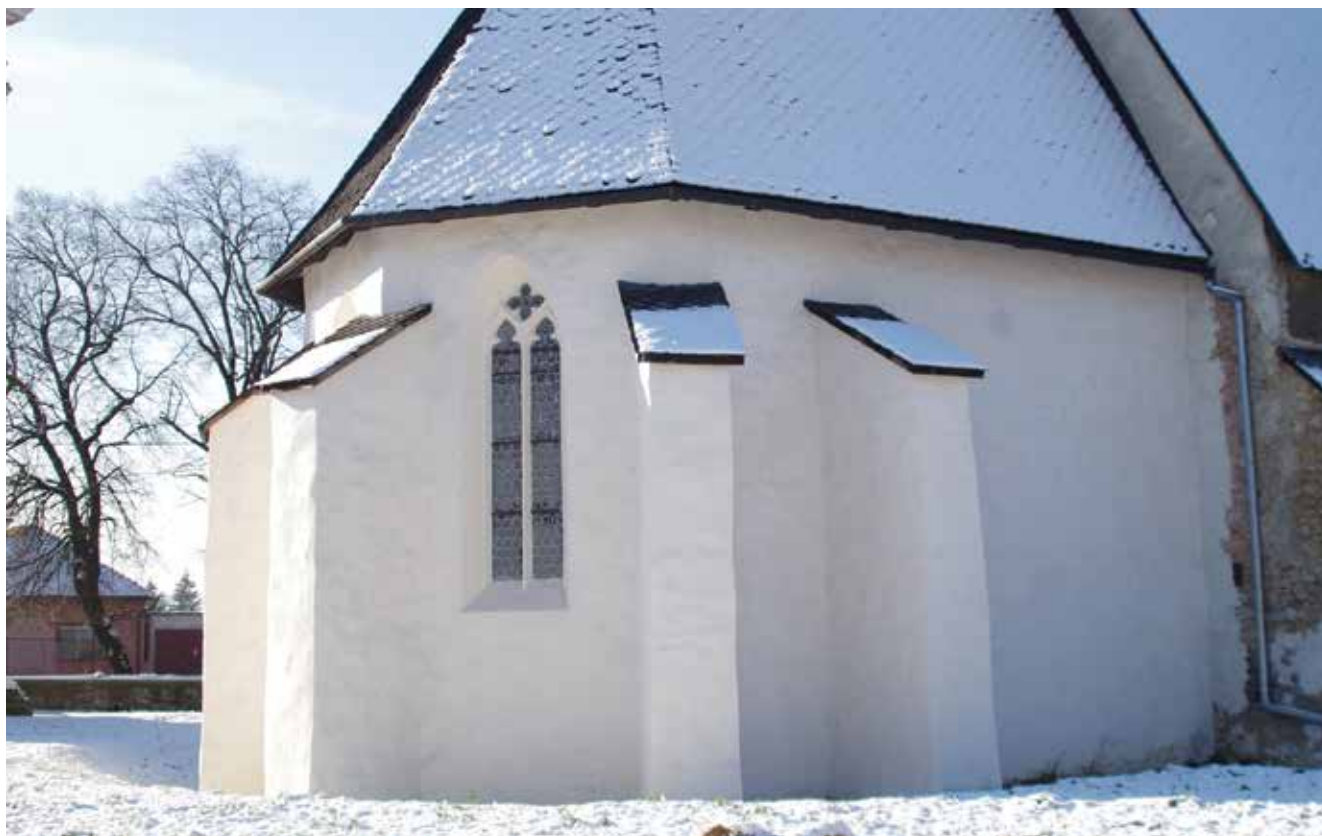
15. Szentély északi fala rekonstrukció után
