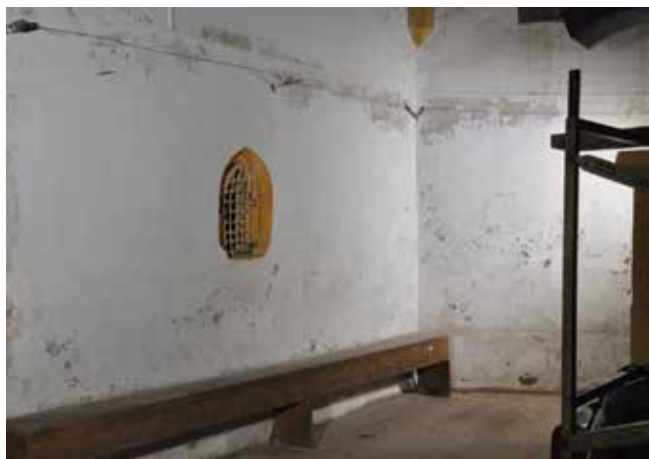
1. kép: A szentély északi fala normál felvételen. Az alsó részen látszanak a felszálló nedvesség okozta károk.
